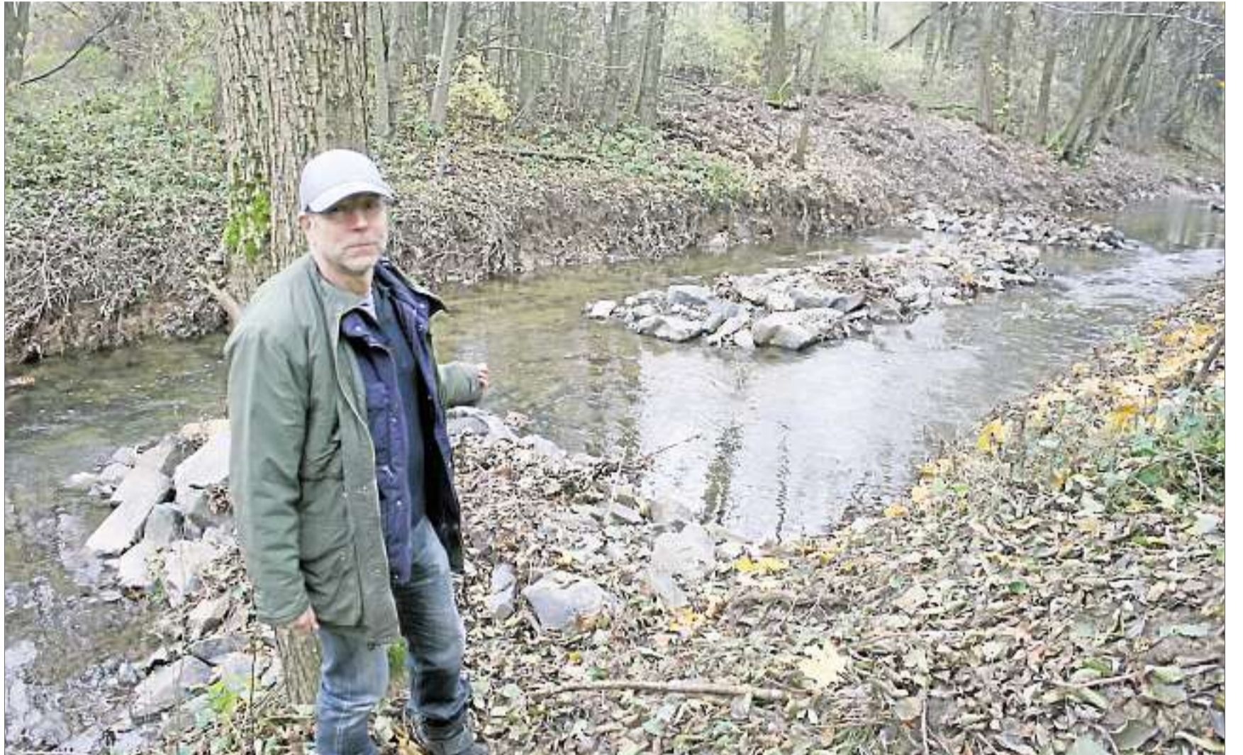
Wieder eine Renaturierung: An der Erlenbachmündung in Massenheim wurden Uferbefestigungen mit Steinen abgebaut, die Steine bilden jetzt Flussinseln. Das Ufer könne nun ein neues Profil bilden, erläutert der Gewässerökologe Gottfried Lehr. Fotos: Dieter Deul, Archiv
